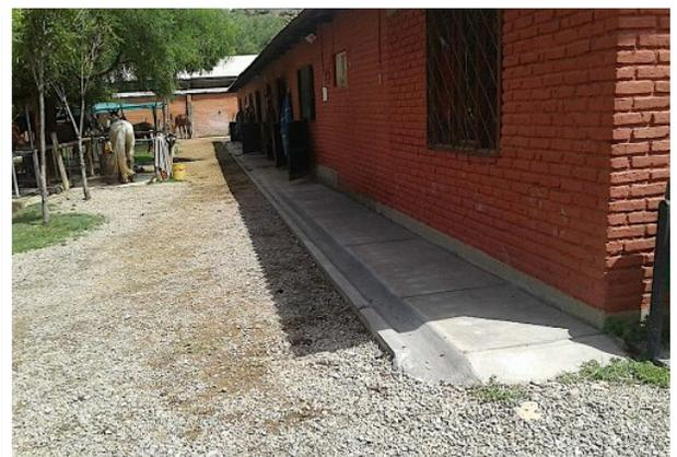
En la Sección Hípica, se construyeron 140 metros lineales de aceras provistas de canales de drenajes, para evitar la acumulación de agua.
